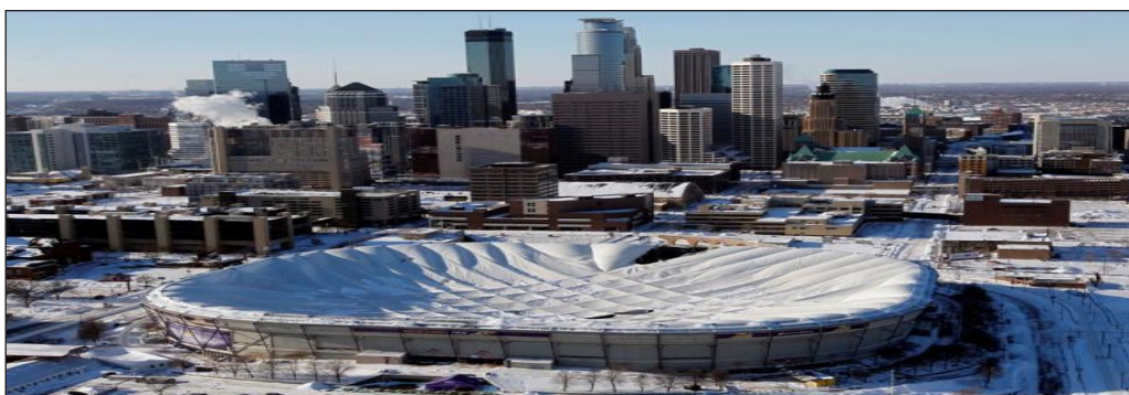
Рис. 1. Обрушение стадиона в Миннеаполисе в 2010 г.
